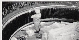
発電機固定子コイル巻替
